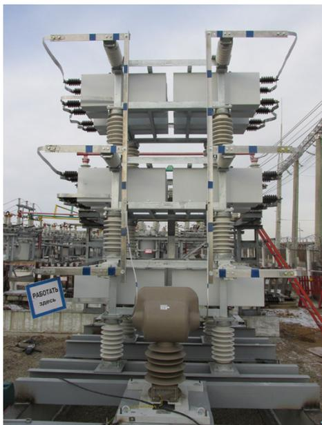
Возможно изготовление БСК с параметрами лежащими в следующих диапазонах: напряжение 6...220кВ, мощность 1...104 Мвар. Также возможно изготовление БСК с антирезонансными (фильтровыми) реакторами для сетей с повышенным содержанием токов высших гармоник, а также фильтров высших гармоник.
