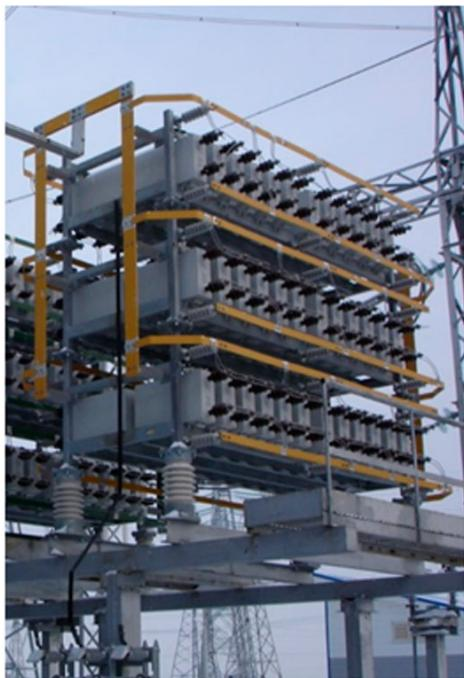
Основное назначение БСК это: компенсация реактивной мощности и регулирование уровня напряжения в сетях 6-220 кВ.
